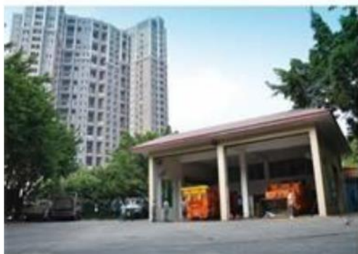
垃圾压缩中转站全貌
