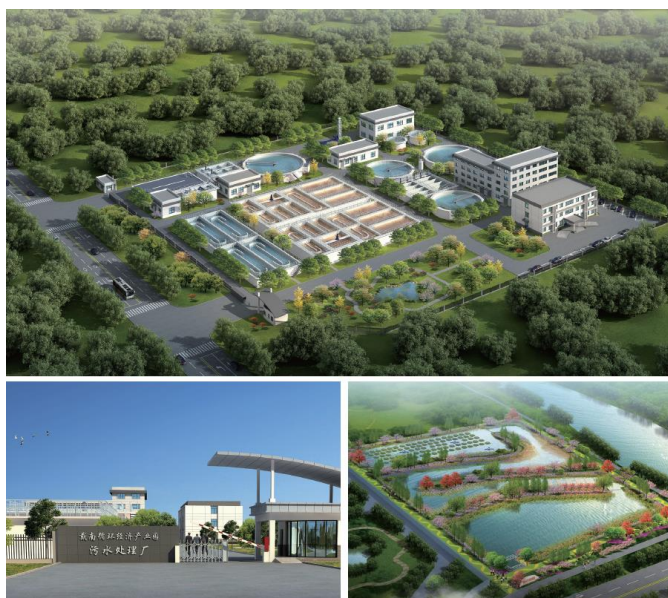
△江苏兴化·戴南循环经济产业园区污水治理工程
