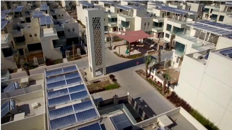
Naseem Townhouses at Town Square Dubai by Nshama 项目采用格力光储直柔多联机系统，光伏电自发自用、就地消纳，从源头实现节能减排，打造发用电一体化、清洁化、直流化、信息化生态。
