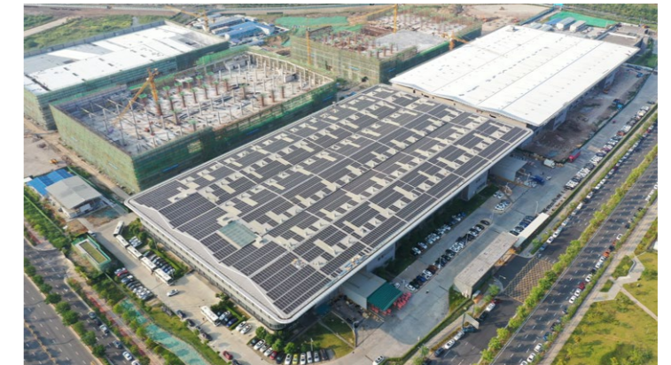
美的微清光储一体化示范项目
