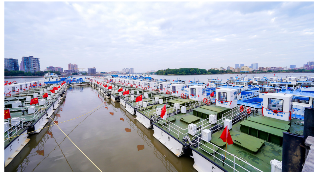
广州市市本级环卫一体化 PPP 项目
