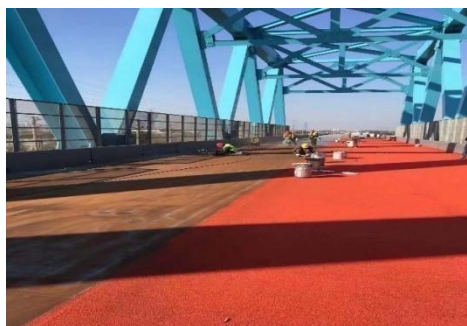
桥梁工程防水
