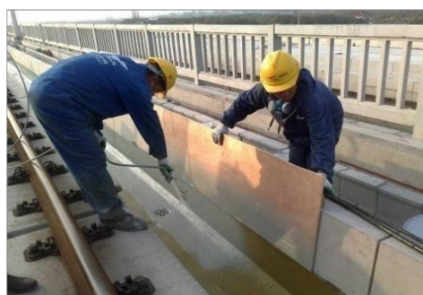
轨道建设防水
