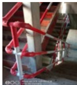
楼梯定型化防护
