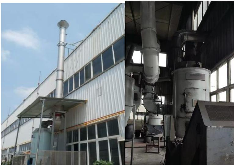
②抛丸粉尘：经文丘里湿式除尘器处理后通过3根15m高的排气筒高空排放。
