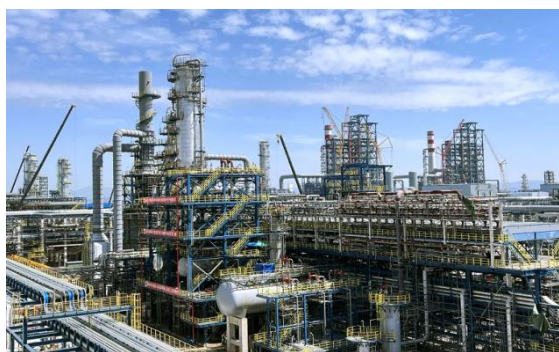
图9：NCC钢结构应用于石油化工领域
