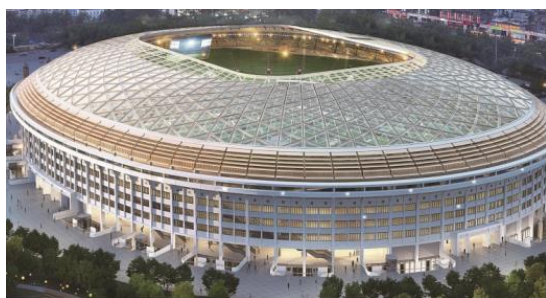
北京工体改造项目
