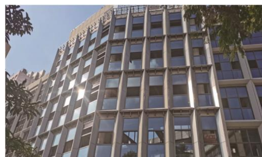
上海建科科研办公楼
