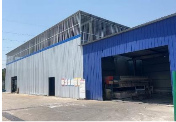
废水处理设施现场图
