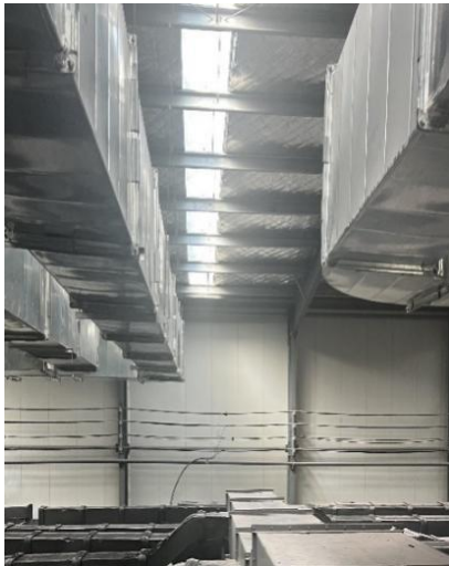
车间管路改造
