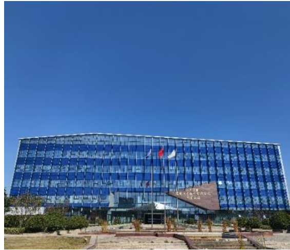
行政大楼幕墙光伏发电工程
