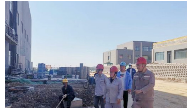
建设现场专项检查
