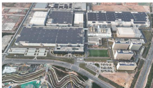
惠州华星屋顶光伏
