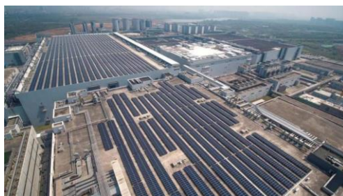
武汉华星屋顶光伏
