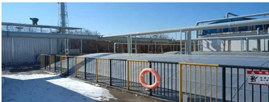
图：污水处理站污水池废气收集装置
