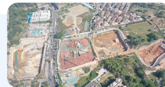
观澜蚌岭项目现场
