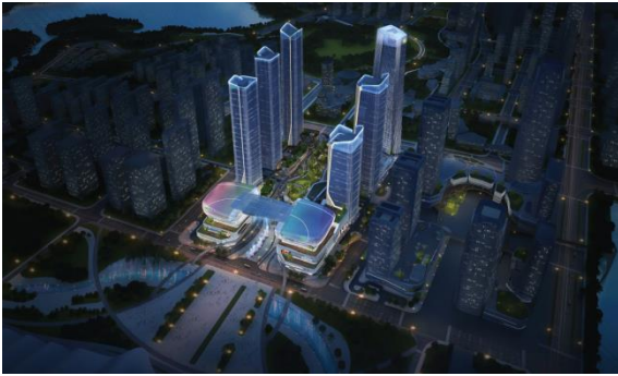
新建商务、商业设施、绿地与广场项目 (杨春湖启动区 A 地块) T2、T3 塔楼泛光照明分包工程
