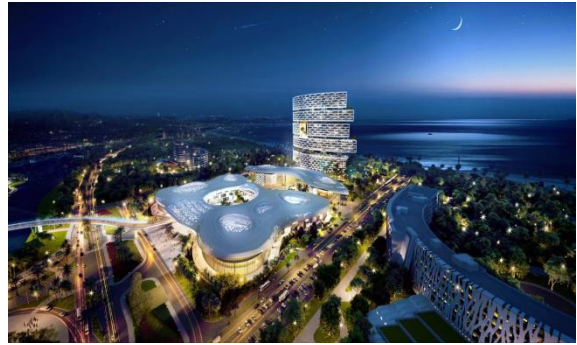
三亚国际免税城一期二号地 商业项目泛光照明工程专业承包
