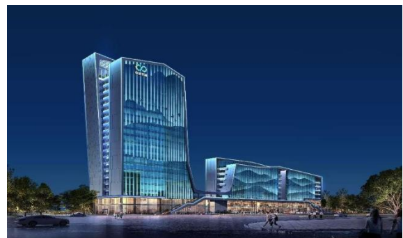
烟台国际节能环保科技园 绿色建筑 2.3 期泛光照明设计
