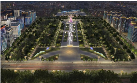
城市生态与人居环境改善治理项目 (节点改造及部分亮化) 设计-施工 EPC 工程总承包
