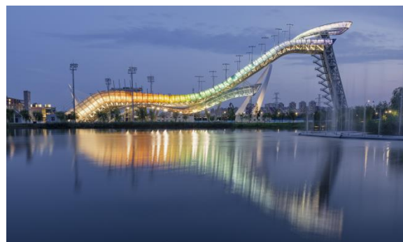
首钢滑雪大跳台中心项目
