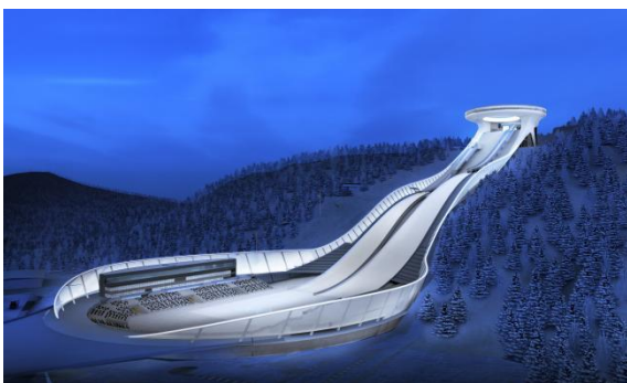
北京 2022 年冬奥会和冬残奥会张家口赛区张家口奥运村及古杨树场馆群建设项目-北欧中心跳台滑雪场（国家跳台滑雪中心雪如意）智慧照明系统及智慧夜游运营系统工程 EPC 总承包
