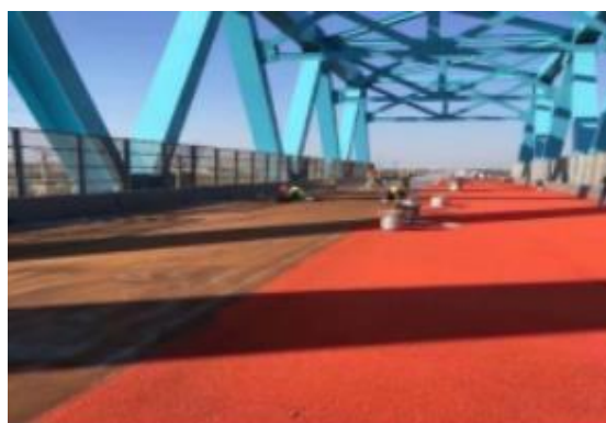
桥梁工程防水
