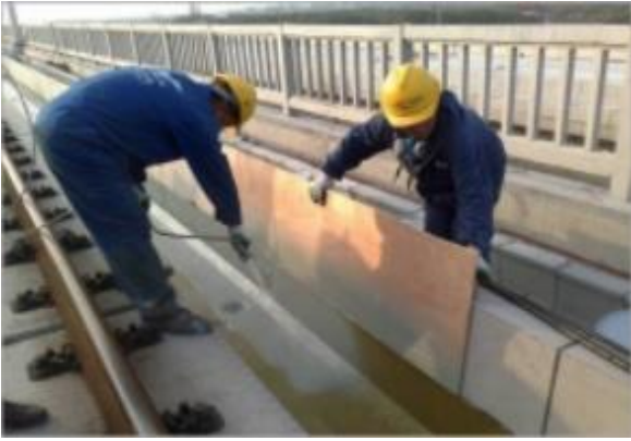
轨道建设防水
