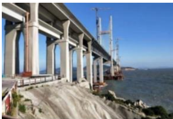
高铁混凝土桥梁防水
