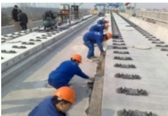
轨道建设工程施工服务
