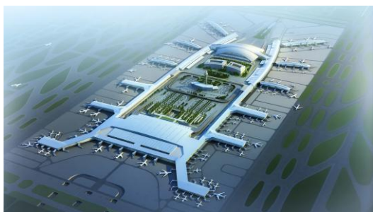
广州白云国际机场 T2 航站楼 (全国绿色建筑创新奖一等奖)
