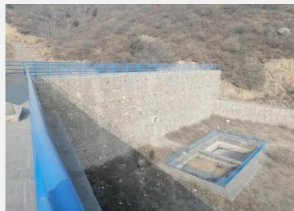
碎石场拦砂坝
