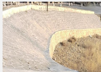
边坡治理工程
