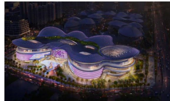
海口市国际免税城项目（地块五）泛光照明专业承包工程
