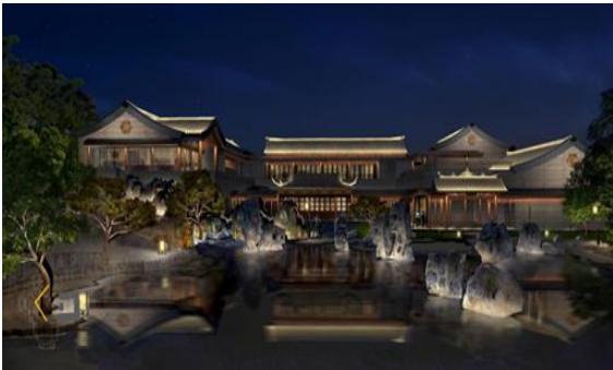
文昌湖区文昌书院配套服务设施建设 EPC 项目 泛光照明工程施工
