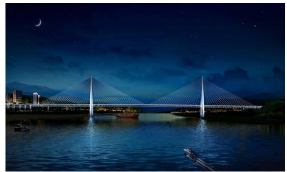
重庆白居寺长江大桥景观灯饰工程
