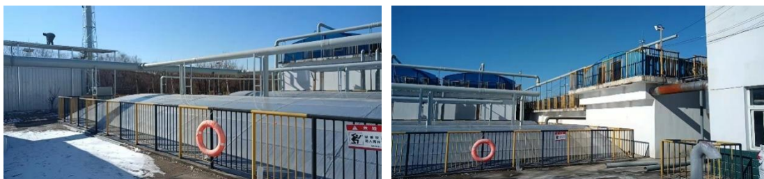
图：污水处理站污水池废气收集装
