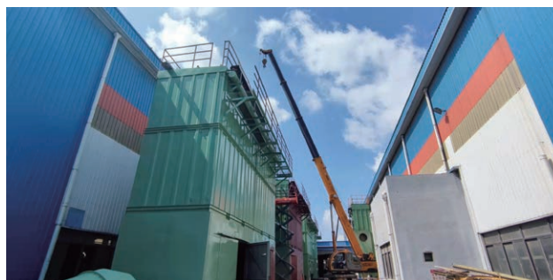
涂装线油改水施工现场
