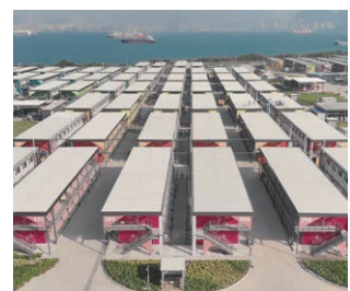
由中集模块化建筑承建的香港竹篙湾检疫中心3A项目
