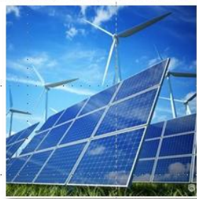
光伏、风力发电及储能
