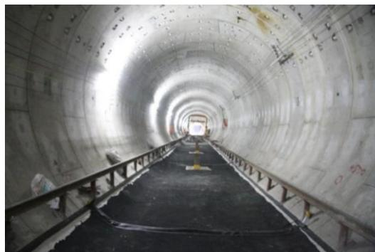
隔离式橡胶减振垫使用效果图
