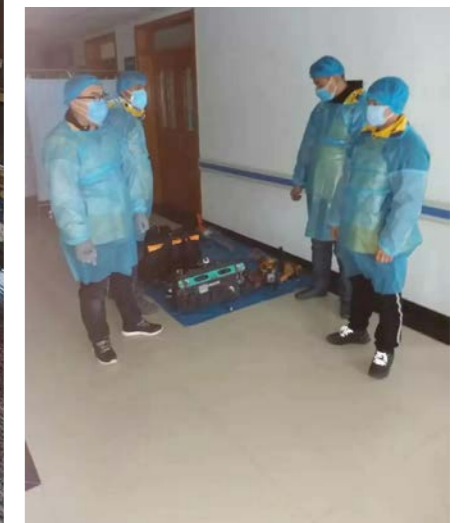
▲ 苏宁帮客安装师傅“全副武装”为烟台莱山区第四人民医院进行空调安装
