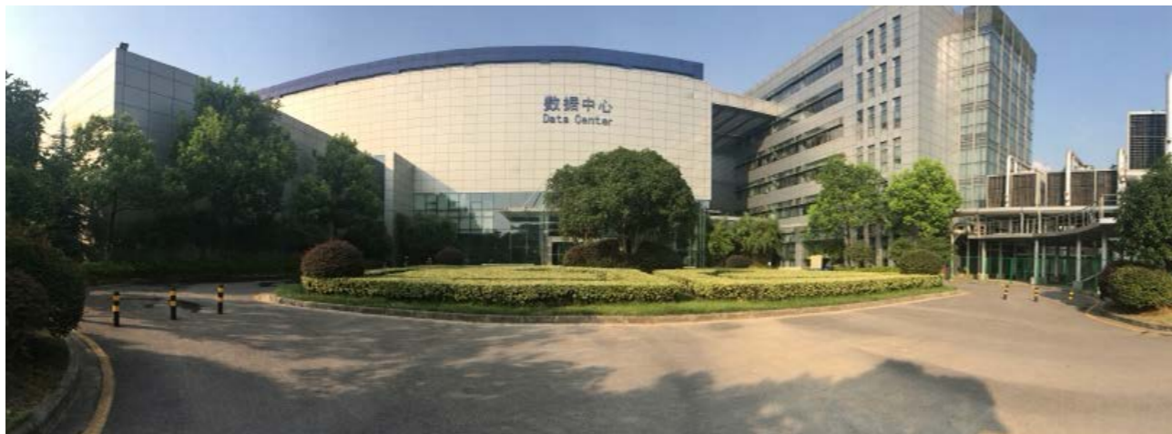
▲ 苏宁数据中心
