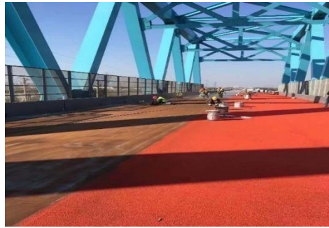
桥梁工程防水
