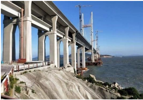
高铁混凝土桥梁防水
