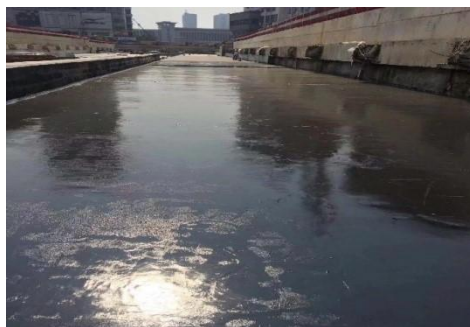
城市轨道交通工程防水
