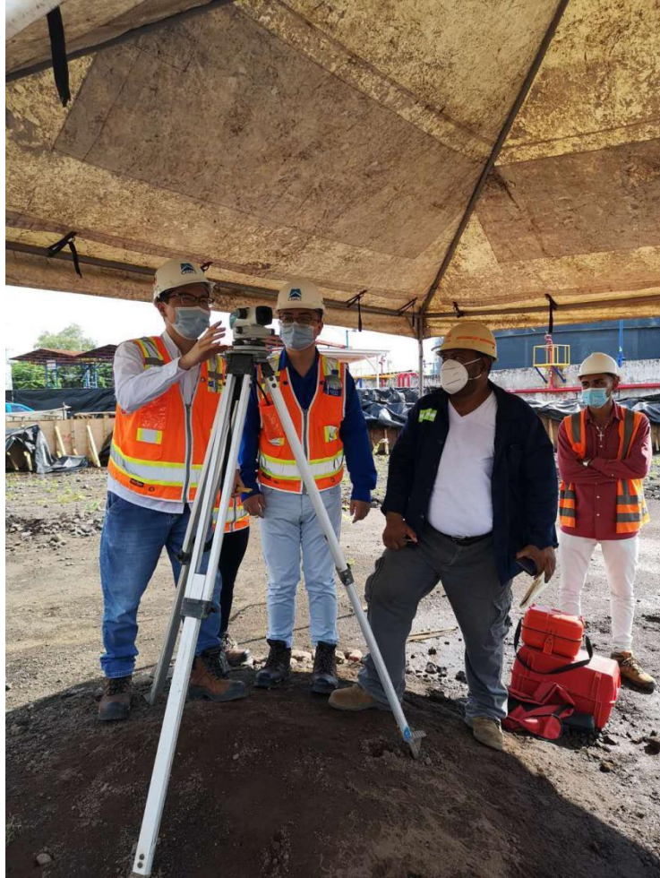
项目部组织储罐基础验收
