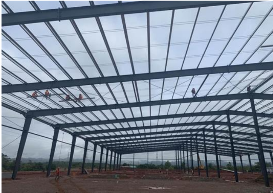
设计优化后的钢结构安装
