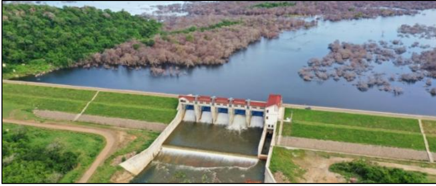
中工国际斯里兰卡延河灌溉项目水库大坝
