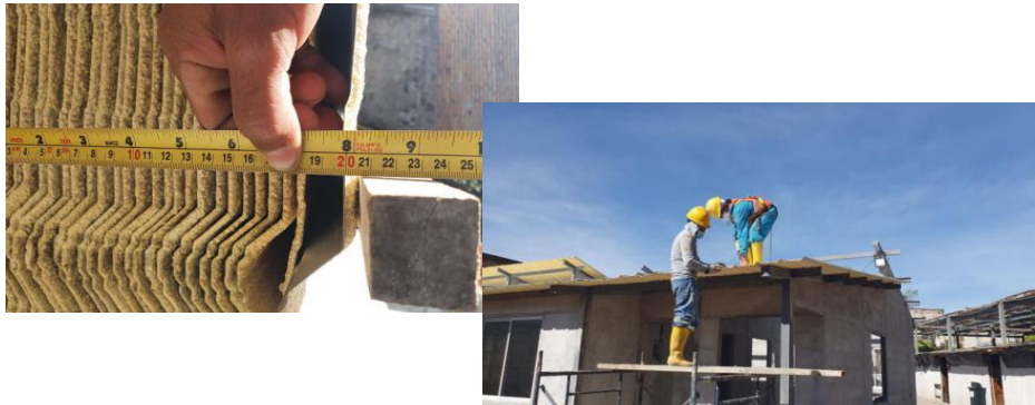
屋面瓦厚度测量
