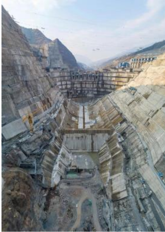
平安银行水电扶贫支持白鹤滩水电站工程建设
