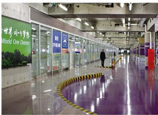
首都机场三号航站楼地下停车场使用公司防火中空玻璃隔断（带钢框架防火玻璃门）
