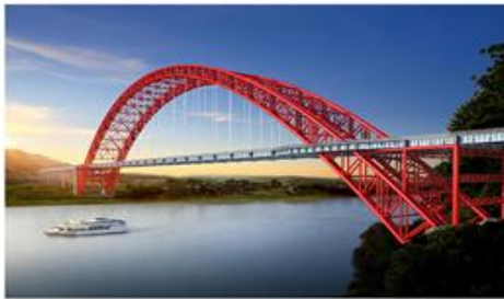
图例：四川犍为岷江大桥
