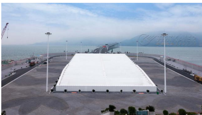
人工岛隧道入口减光罩——侧墙装饰
