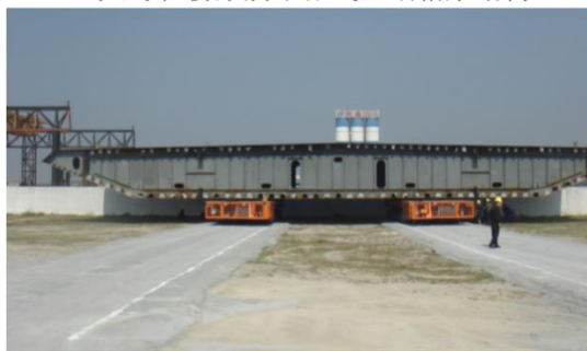
图例：珠江黄埔大桥 钢箱拱桥结构
