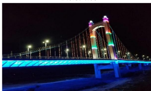
图例：天水市天秀桥 (独塔自锚式悬索桥)
