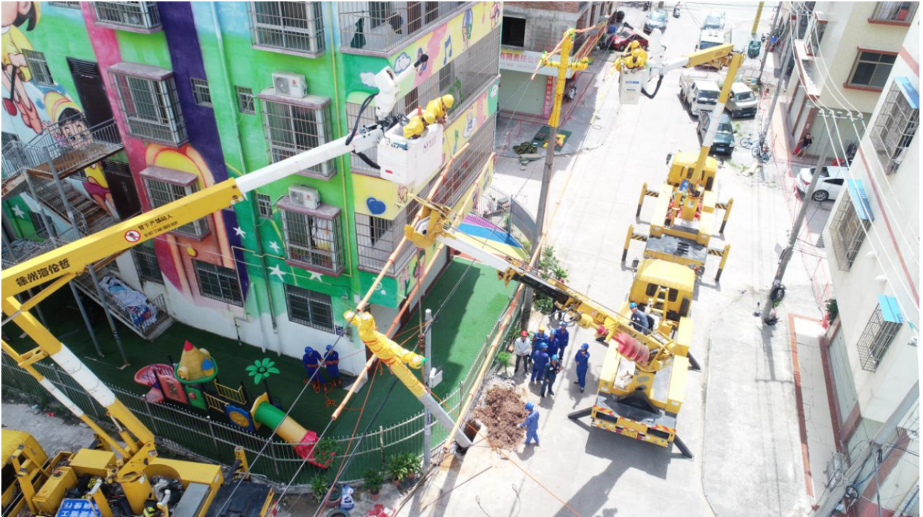
绝缘斗臂车和线杆综合作业车钦州供电局带电立杆换杆作业场景
