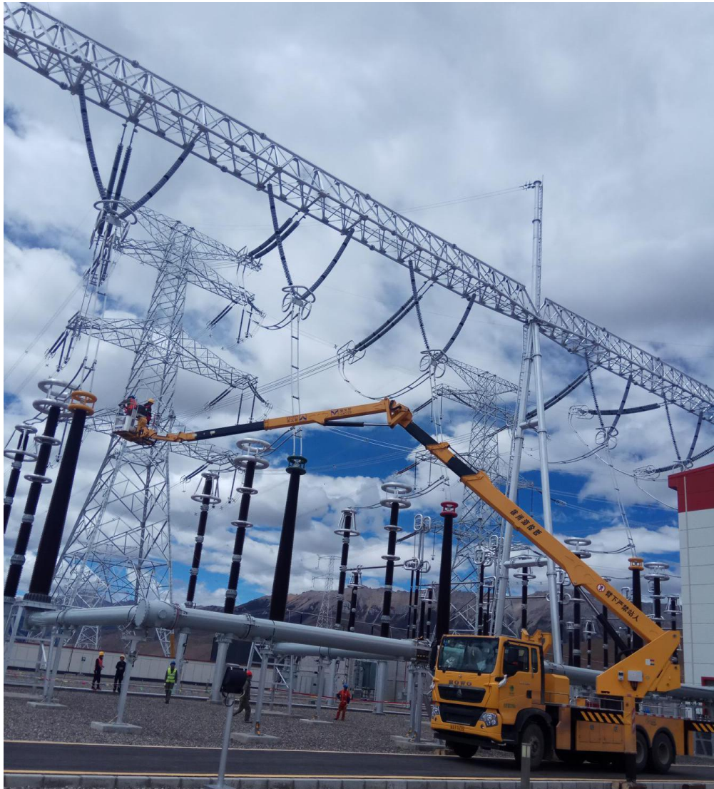
35 米混合臂高空作业车西藏左贡开关站作业场景
