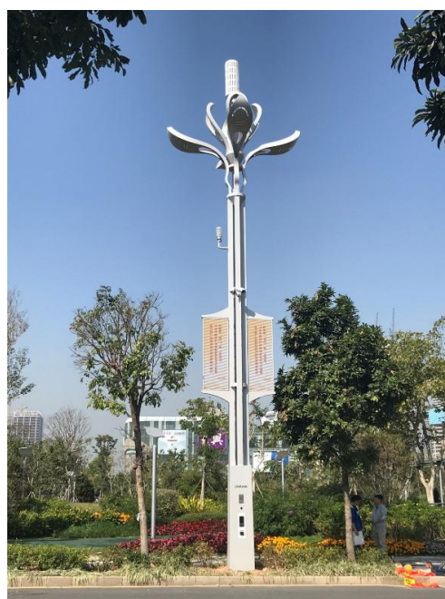
深圳前海紫荆园智慧路灯项目
