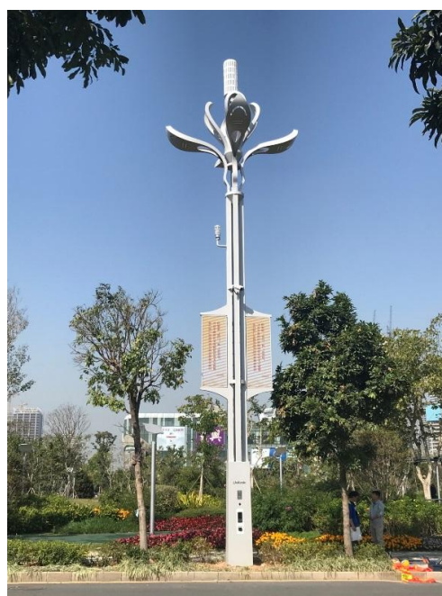
深圳前海紫荆园智慧路灯项目
