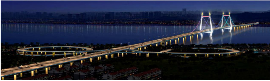
长沙三汊矶大桥
