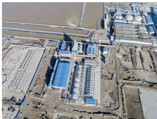
2万吨碳酸锂装置施工现场
