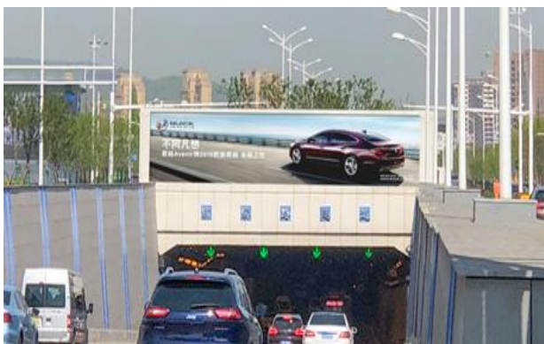
丰德博信：扬子江隧道LED媒体（别克）
