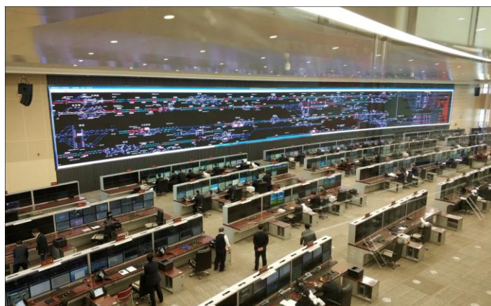
铁路总公司山西集团公司指挥调度系统方案（国内铁路系统首个采用小间距LED显示产品的信息调度指挥中心）
