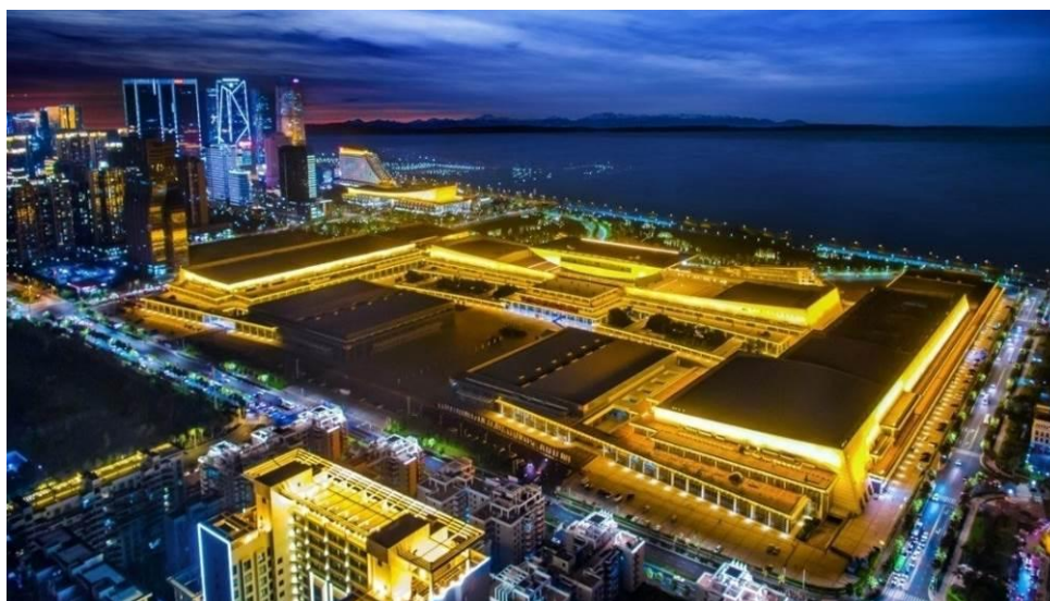
厦门金砖五国会议国际会议中心项目
