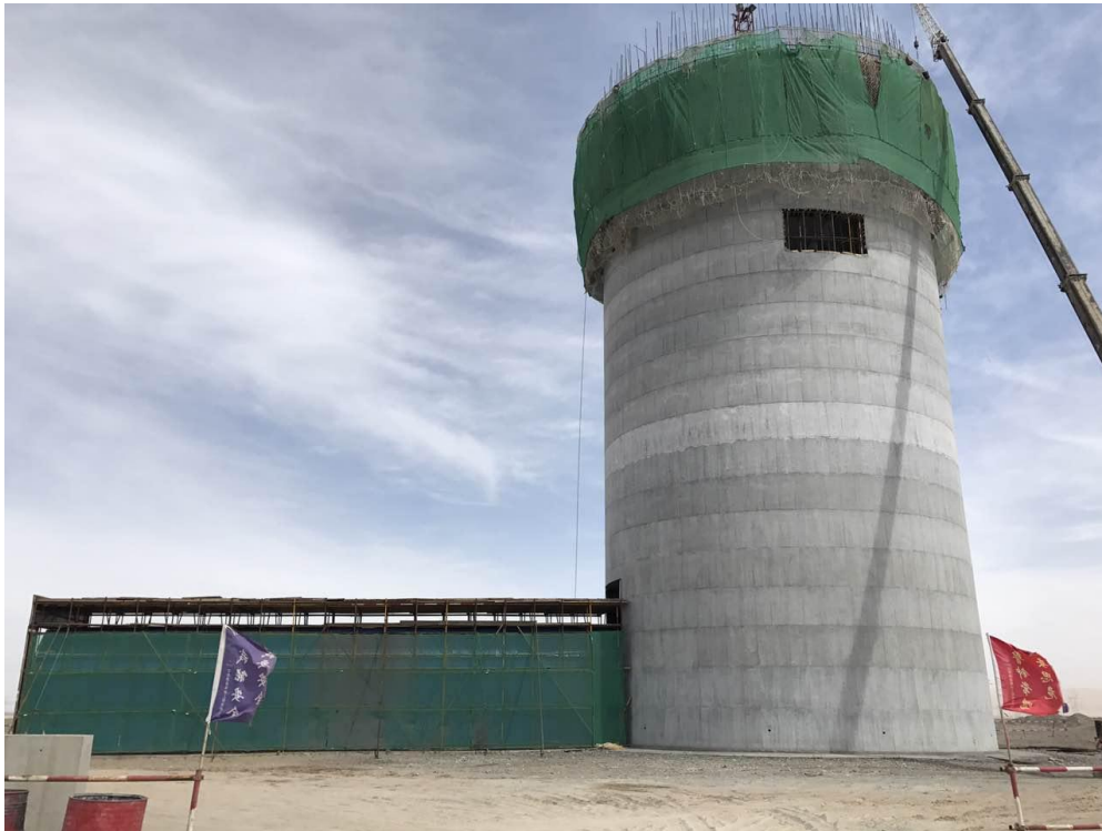
敦煌100MW太阳能热发电项目工程现场图片
