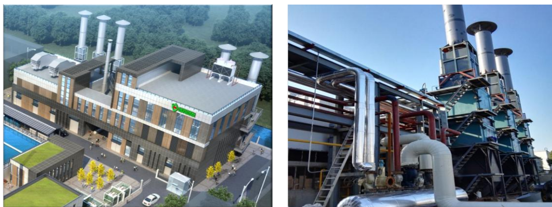
图8 上海老港工业园区分布式能源项目
