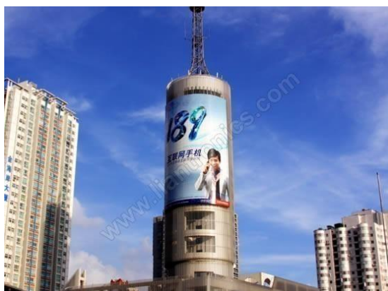
深圳南山区中国电信南油通信机楼，693平米
