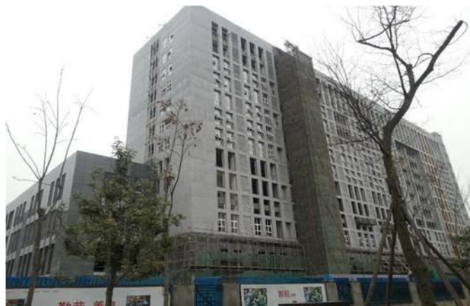
在建的新研发大楼
