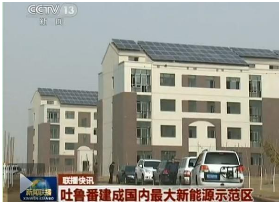
吐鲁番新能源城市微电网示范工程
