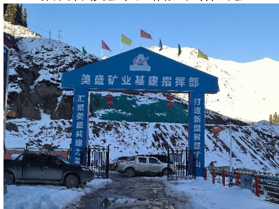
矿山办公区(建设指挥部)
