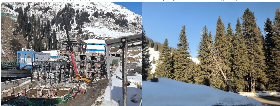
在建选厂-选矿综合车间（三）
