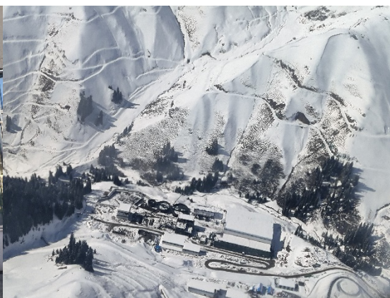
空中俯瞰卡特巴阿苏金铜矿建设全景
