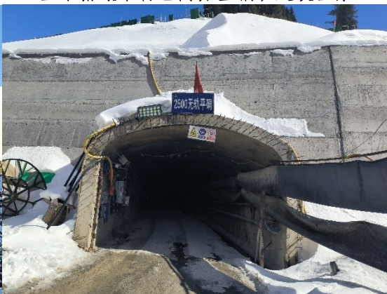
在建的2500米中段平硐口
