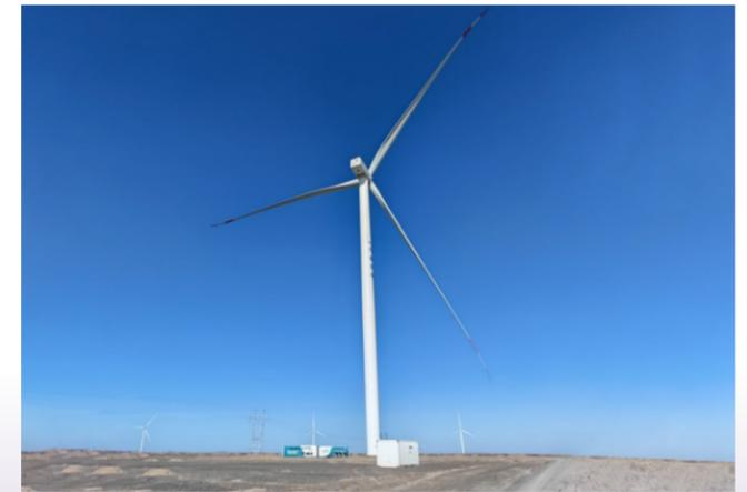
5MW 构网型双馈风电机组
