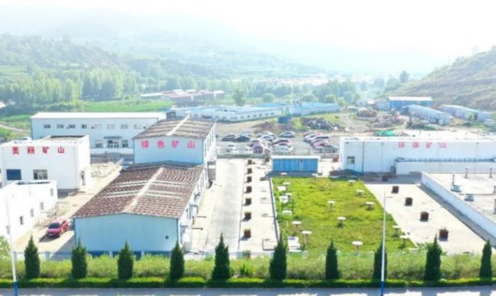
| 煤矿污水处理站
