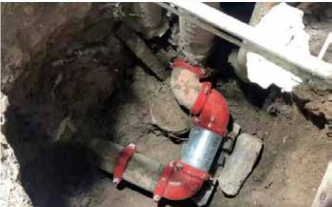
天津公司 管网改造
