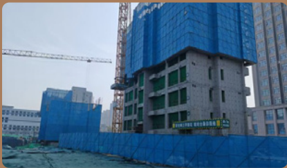
裸土覆盖措施
