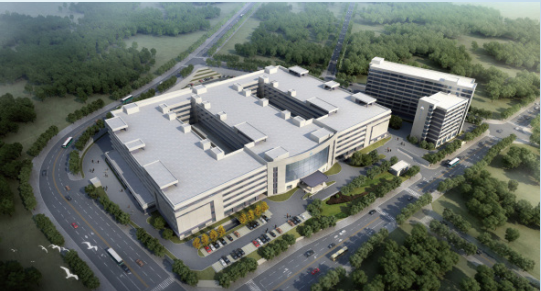
厦门产业基地
